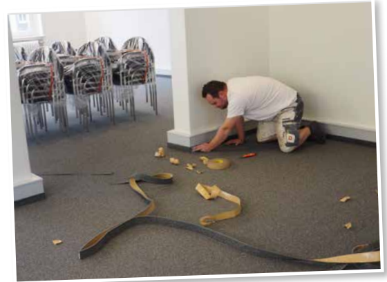
Der Fußboden im Saal ist fast vollständig verlegt. Im Hintergrund die neuen Stühle
