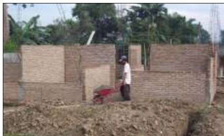
März 2008: Die Baustelle, auf der die beiden Mädchenhäuser entstehen.
